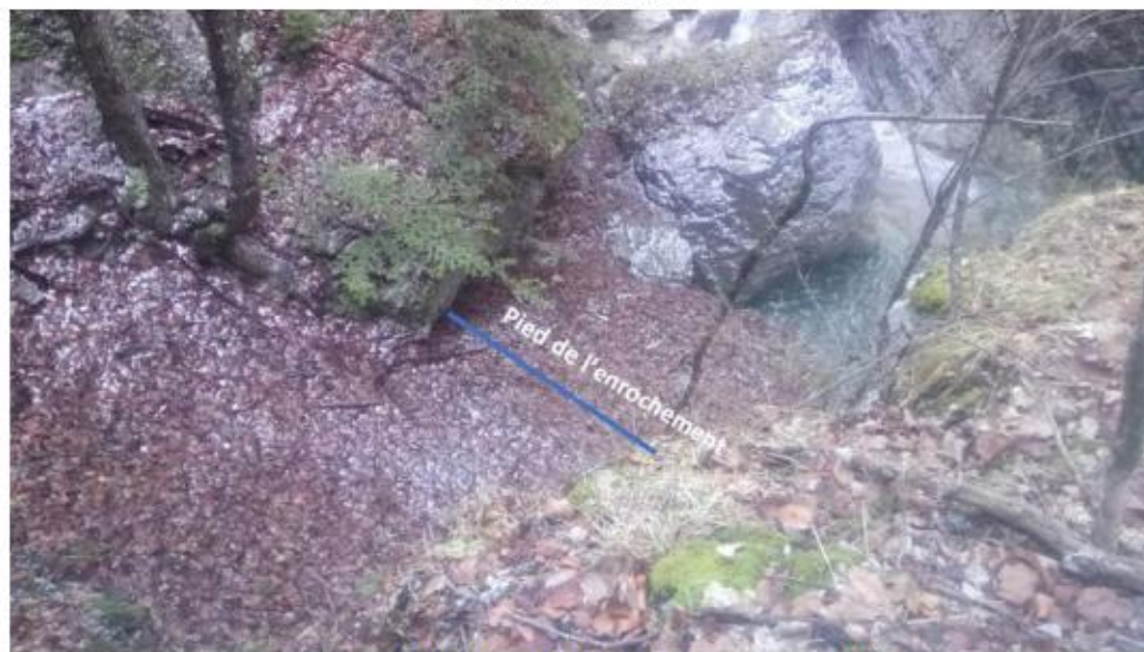
Implantation du pied de l'enrochement – vue de dessus - Alp Études
