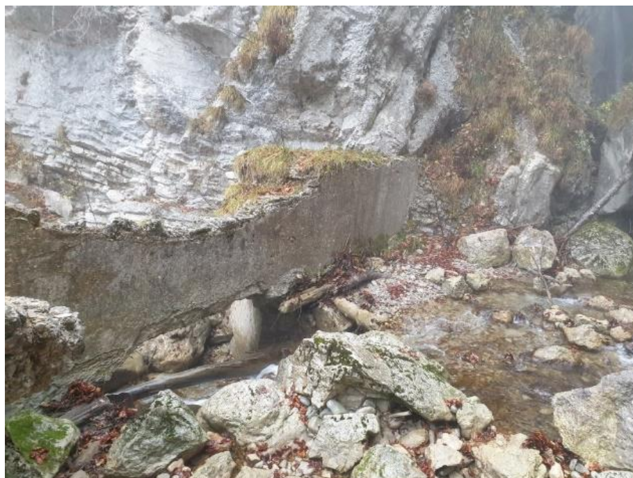
5 VUE SUR LES VESTIGES DE L'ANCIENNE INSTALLATION
