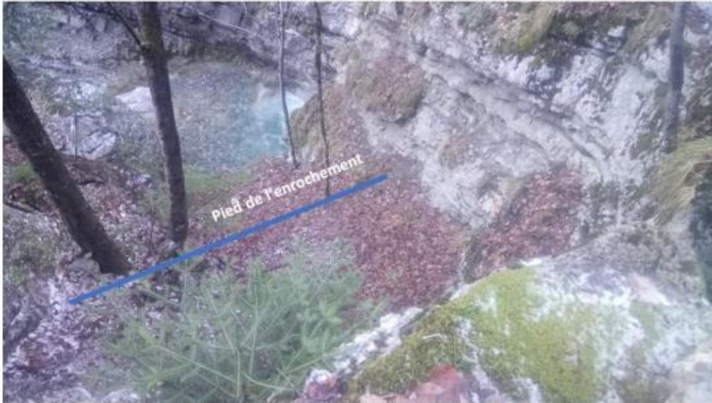
Implantation du pied de l'enrochement – Vue de côté - Alp Études
