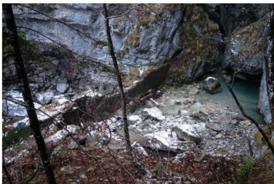
Vue de l'emplacement de la future prise d'eau (Source : Pièce 4 Description du Projet p 7) ECEAU
